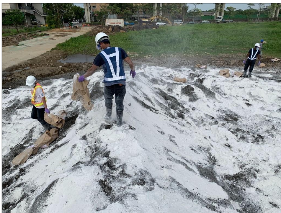
圖 4-2 現地添加石灰情形
